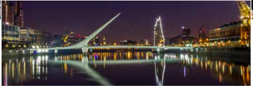
Puente de la Mujer, Puerto Madero
